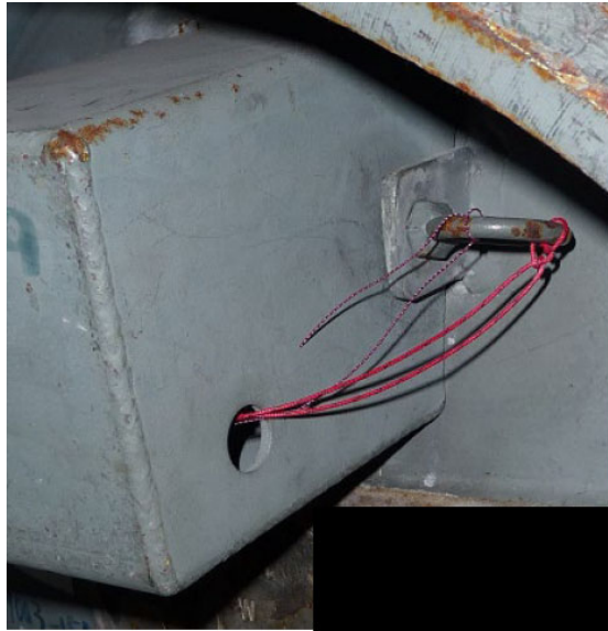
③写真 毀損した査察用封印(2)
